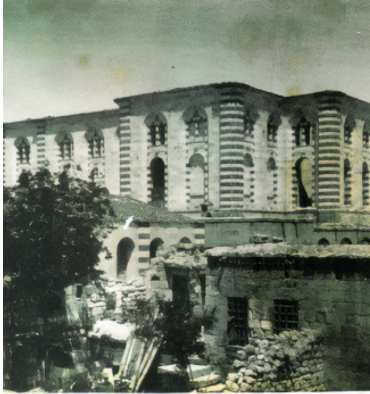
Sultan II. Abdulhamid Albümünden alınmıştır. 1890 Kilise inşaat halinde iken, daha kubbesi yapılmamış.
